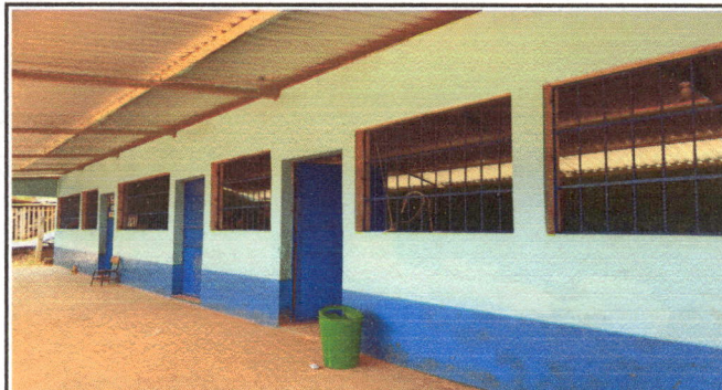
Foto 2: INSTALACION DE LOS 8 BALCONES EN LAS VENTANAS DE LAS AULAS DE ESTE CENTRO EDUCATIVO.
