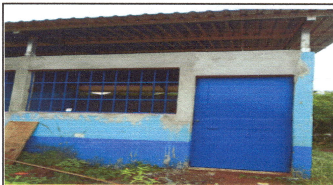
Foto 4: COLOCACIÓN DE LA PUERTA DE METAL CON CHAPA DEL ULTIMO AULA MEJORADO.
