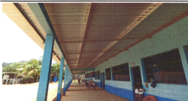
Foto 1: EL ENTECHADO FINALIZADO CON LAS COSTANERAS DE METAL Y LAMINA TROQUELADA.
