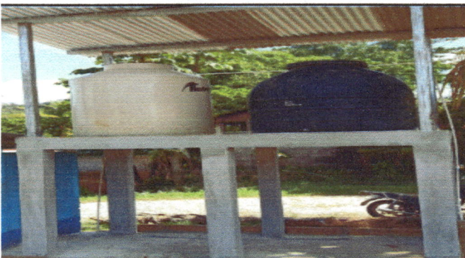
Foto 3: TARIMA FINALIZADO CON LOS DOS TINACOS PARA ABASTECER DE AGUA LOS BAÑOS LAVABLES.
